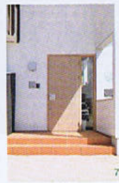
7.玄関ドアは断熱性のあるレッドシダーのむく材を使ったオリジナル。サイドの窓は、高断熱のLow-E仕様の複層ガラスを採用した
