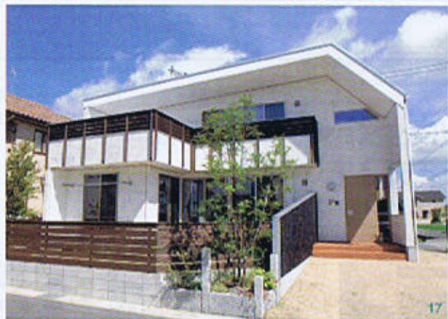
17. 2階の軒を大きくせり出させたMさん宅。陽差しを反射させる効果のある白色を外壁に用い、黒い茶の焼きスギでアクセントを付けた
